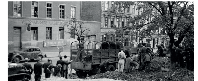
Aufräumarbeiten in der Hellmundstraße, 1945 Fotoquelle Rudolph, StadtA WI F006093
